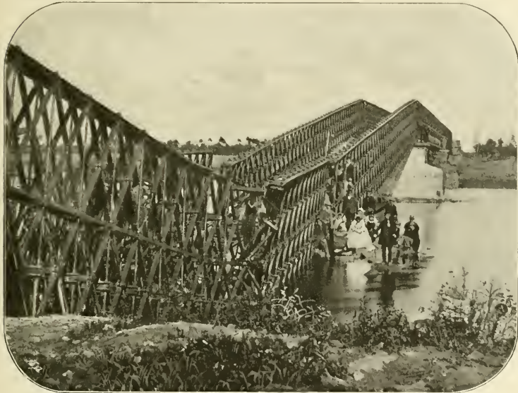
Abb. 22. Eisenbahnbrücke über die Elbe bei Neratowitz nach der am 28. Juli 1866 stattgefundenen Sprengung. [Nach einer photographischen Aufnahme von H. Eckert in Prag.]
